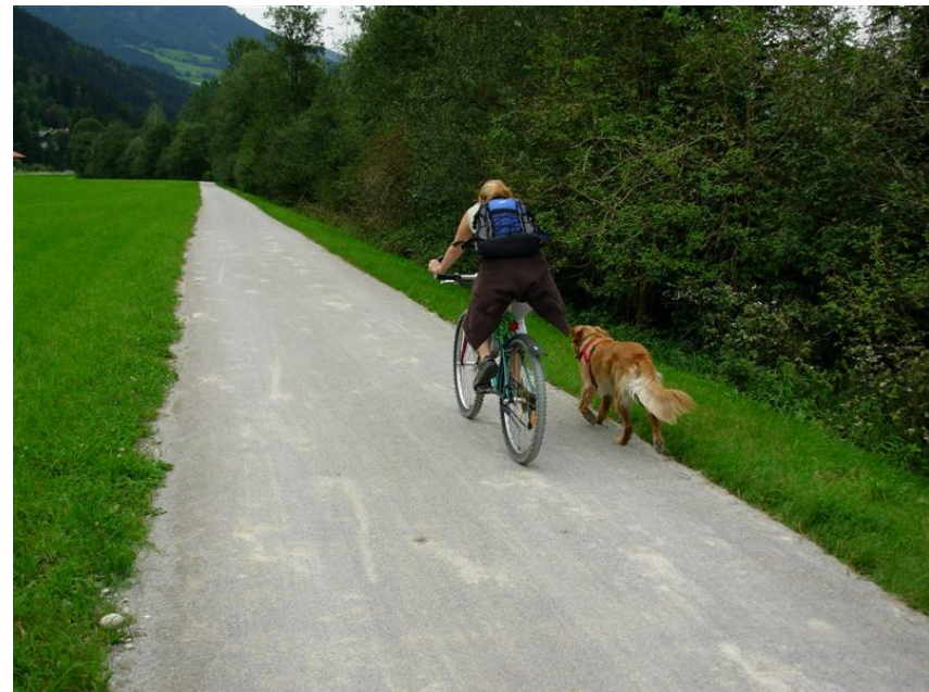
Radwegabschnitt mit wasserdurchlässiger Kalk-Bruchsanddecke
