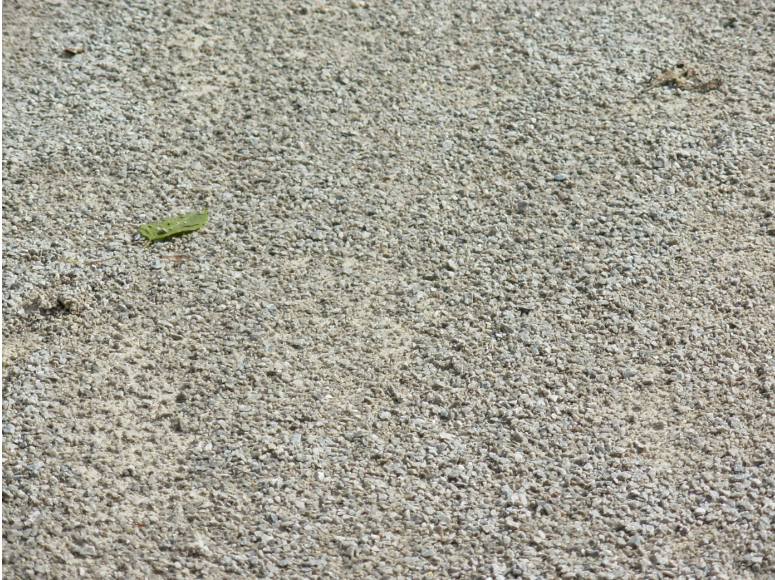
Abbildung 5: wassergebundene Schotterdecke Detailaufnahme
