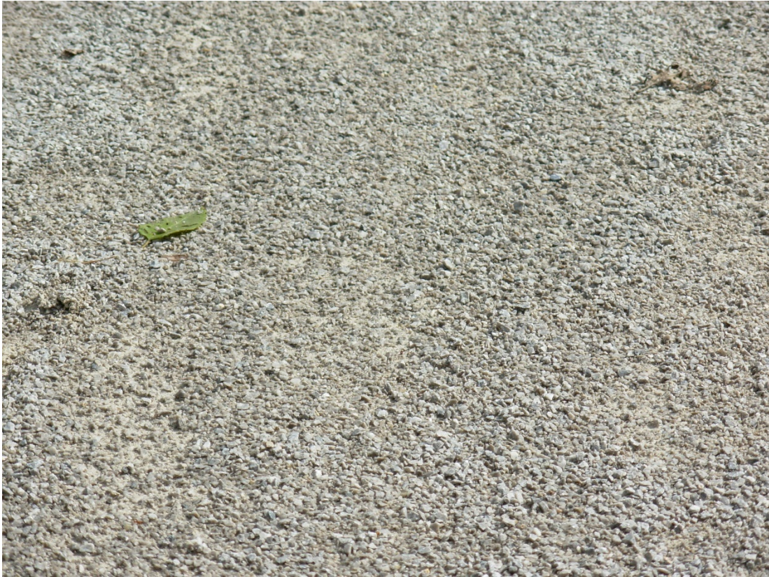
Abbildung 5: wassergebundene Schotterdecke Detailaufnahme
