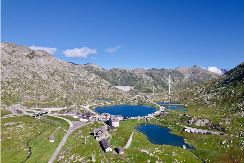
Abbildung 4: gesamt fünf Anlagen, Rotodurchmesser 92 m, Nabenhöhe 98 m; Gesamtleistung 11,75 MW (Foto von Michael Derrer Fuchs via iStock , unbearbeitet).
