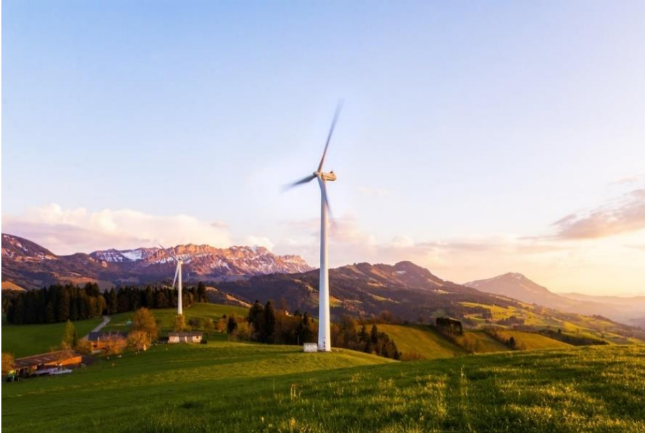
Abbildung 3: zwei Anlagen, Nabenhöhe 61/50 m, Rotordurchmesser 52/54 m, ~ 1,85 MW Leistung (Foto von lukasbieri via Pixabay , unbearbeitet).
