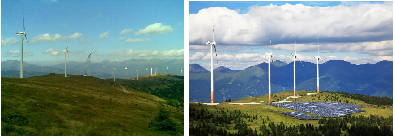
Abbildung 2: Links - vor dem Repowering, Höchstanzahl an Anlagen: 14 (Foto von library_mistress via Flickr , unbearbeitet); Rechts - Nach dem Repowering, gesamt 10 Turbinen und zusätzlich Photovoltaik-Freiflächenanlage. Gesamtleistung ca. 32 MW (Foto von Klimafonds/Barbara Krobath via Flickr , unbearbeitet).
