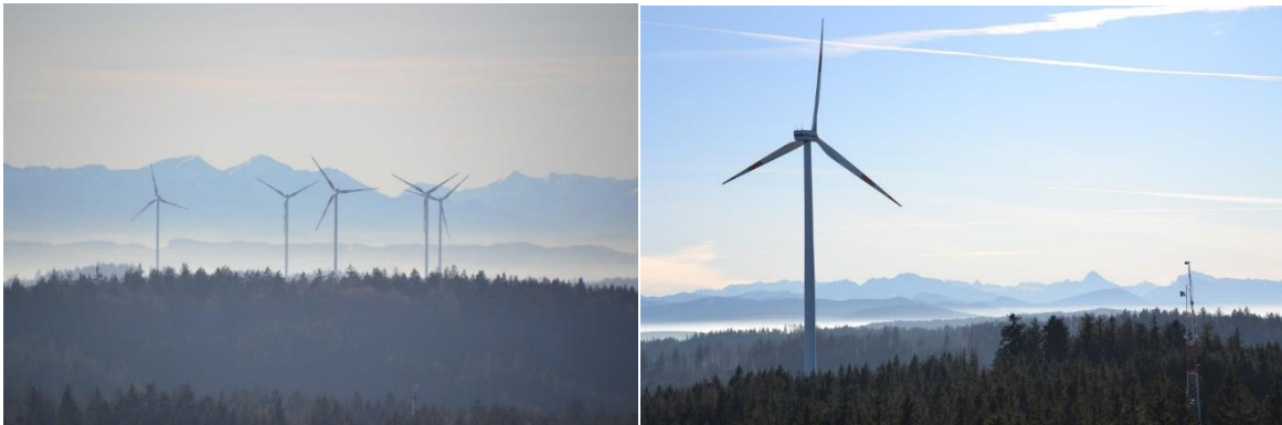
Abbildung 1: Links - Windpark ursprünglich mit 5 Windrädern (Nabenhöhe 140 m, Rotordurchmesser 112m); Rechts - 2022: sechstes Windrad (Nabenhöhe 166 m, Rotordurchmesser 136 m); Gesamtleistung derzeit ca. 19 MW (Fotos von Innviertlerin via Pixabay , unbearbeitet).
