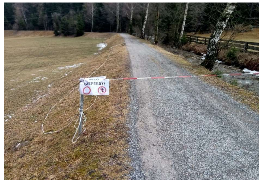
(Der betroffene Wegabschnitt vor der Asphaltierung.)
