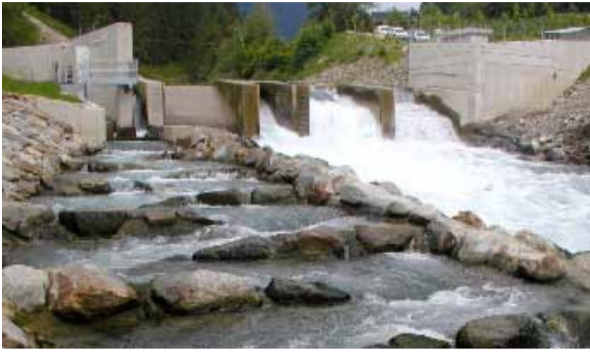
Funktionierende Fischaufstiegshilfe am Kraftwerk Schwarzach der TIWAG AG /Foto: Ch. Vacha
