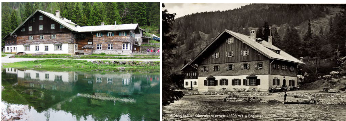
Abbildung 2: Bestand vom Bereich des Rundwanderweges von der gegenüberliegenden Seeseite aus bzw. vor den getätigten Anbauten.
