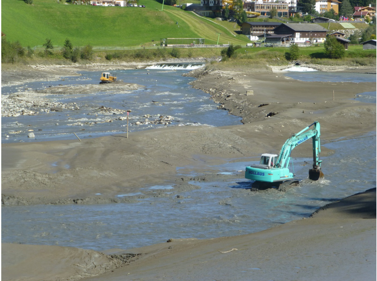
Abbildung. 1: Baggerarbeiten am 29.09.2015 um 14:12
