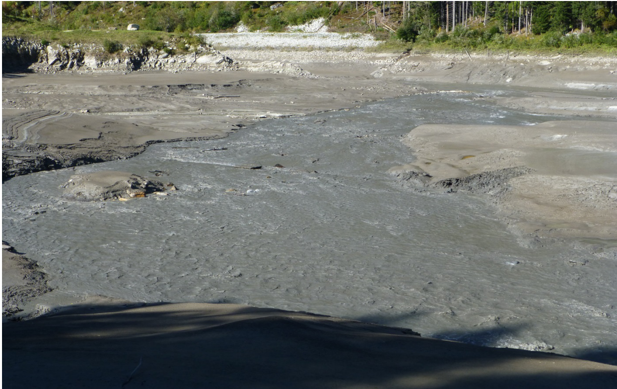
Abb. 2: Wassertrübung während der Baggerarbeiten am 29.09.2015 um 14:16
