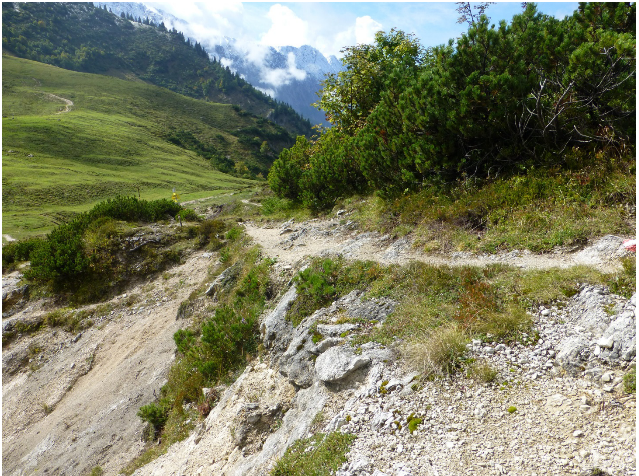
Abbildung 2: Erosionsbereiche am Beginn der geplanten Almwegerrichtung.
