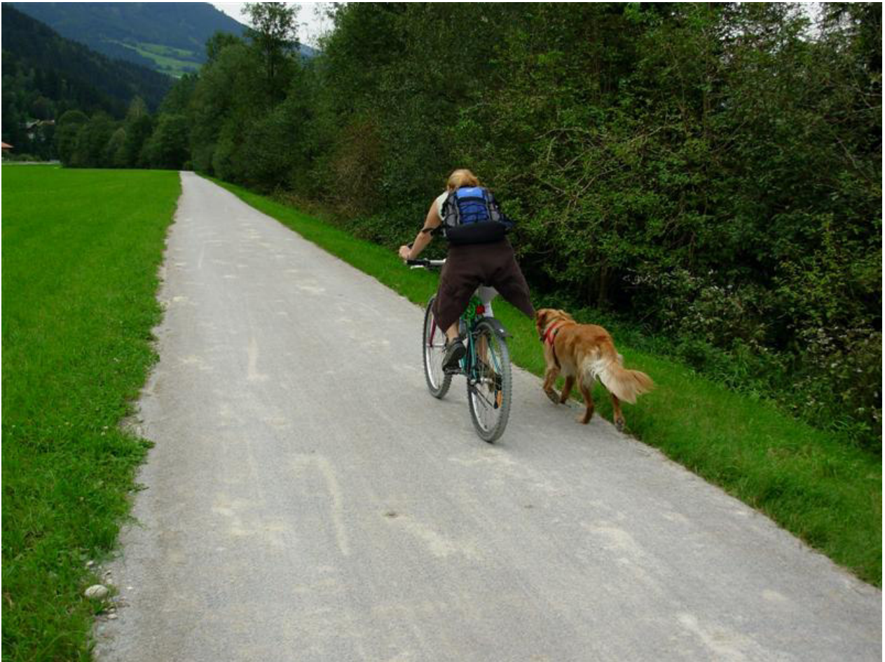
Abbildung 4: Beispiel für eine wassergebundene Schotterdecke (in diesem Fall eine Kalk-Bruchsanddecke).
