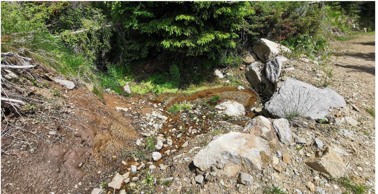
Abb. 3: Entwässerung mit Ausleitung in talseitige Feuchtwiese
