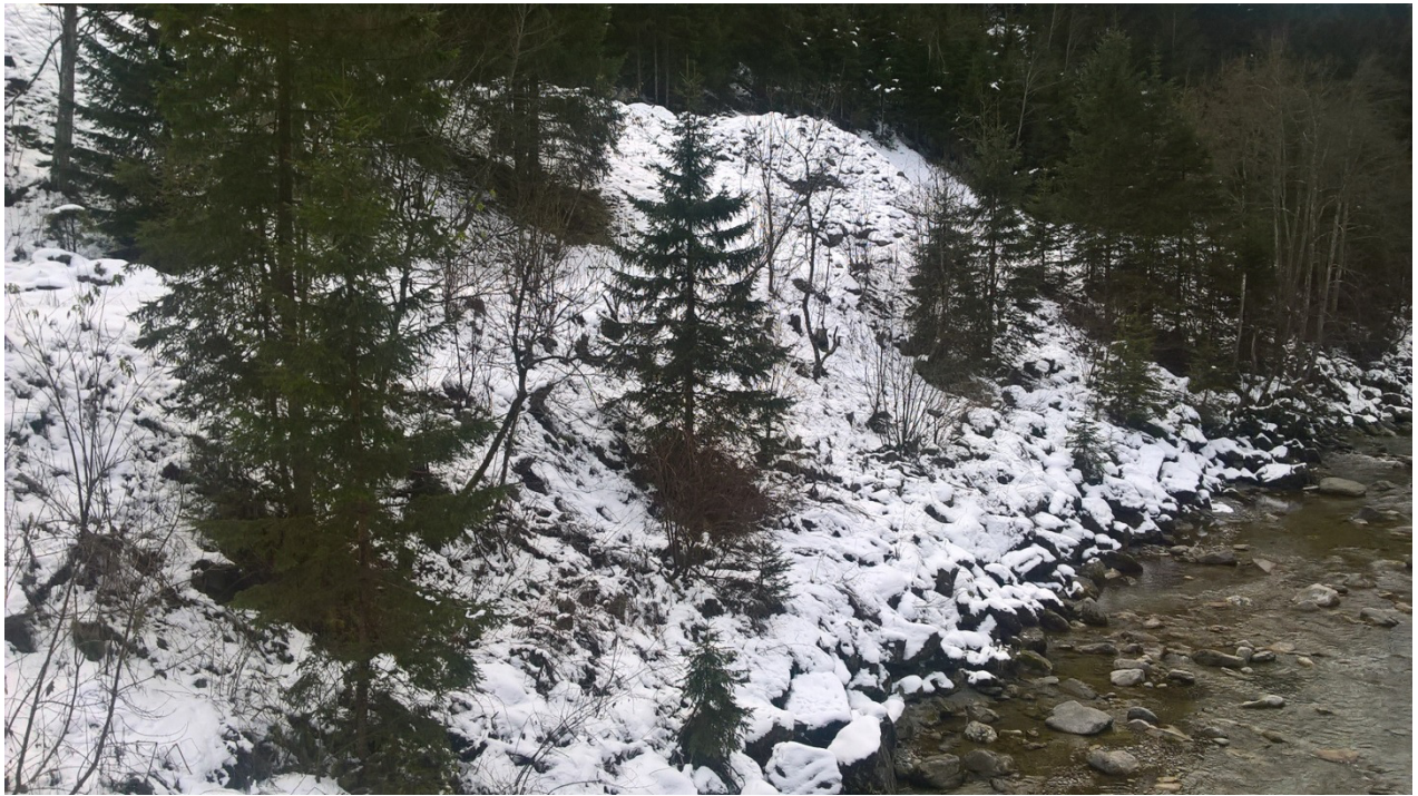
Abbildung 1: Bestehende Uferböschung zum Zembach im Bereich der geplanten Zwischendeponie.
