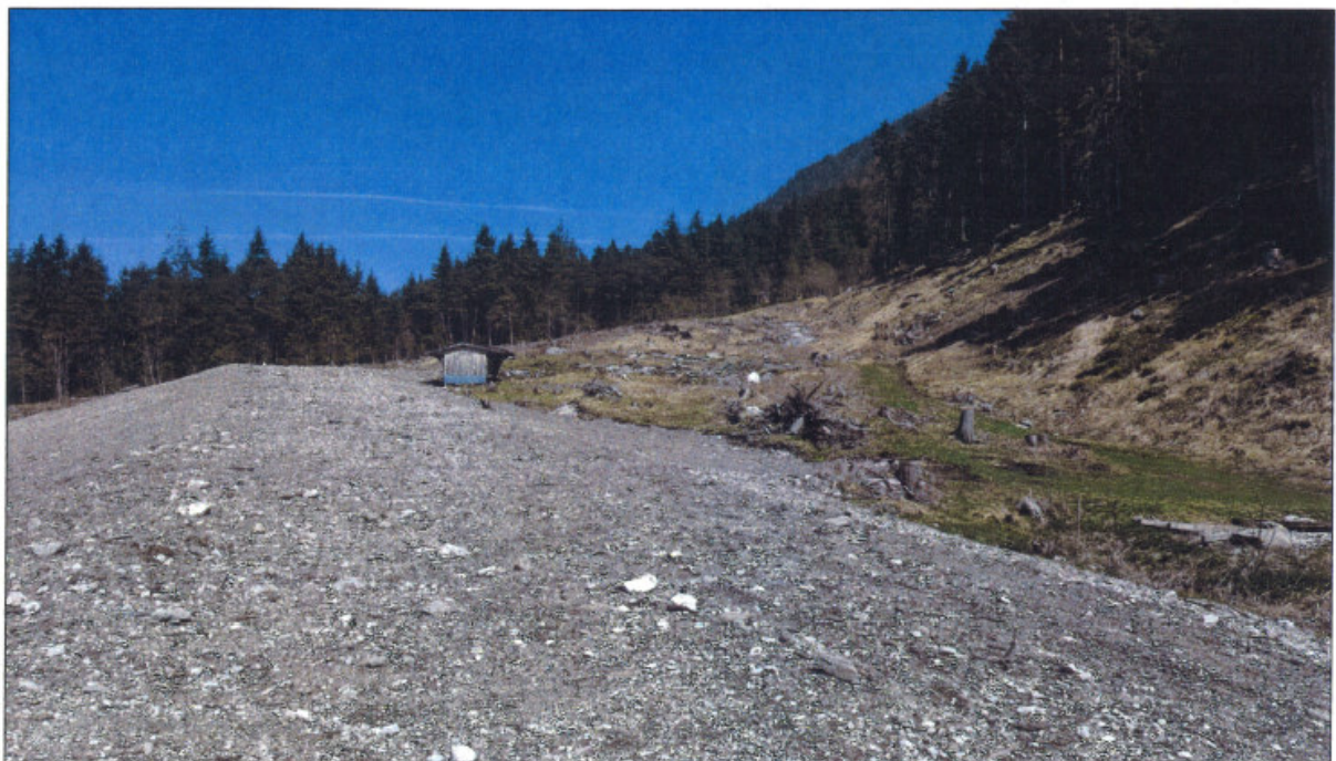
Abb.9: Dammartig zwischengelagertes Material und Schlägerungsbereich oberhalb des Projektgebietes, Blick Richtung Nordost
